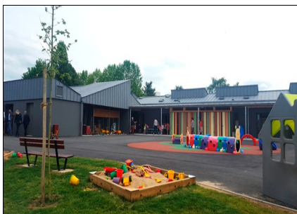
École rénovée Saint Exupéry-le Petit Prince à Doué
